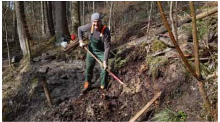
Gesparte Zeit, die genutzt wurde, um an den beiden nassen Stellen oberhalb und unterhalb der neuen Metalltreppe einige Gräben zu ziehen um die sprudelnden Wasserläufe zu bändigen.
